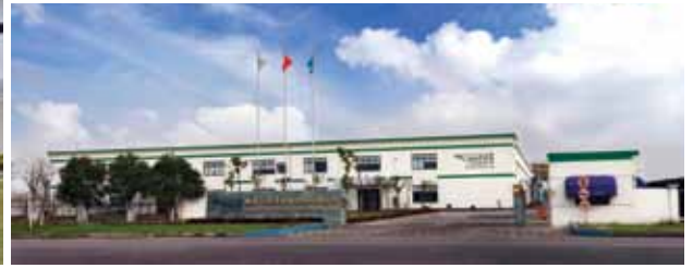
Camfil - Kunshan, China plant.
